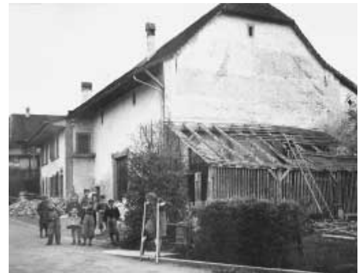
Ansicht des Pfarrhauses von 1550, aus der Zeit, als die 1954 abgebrochene Scheune aus derselben Zeit noch stand (Foto 1954).
