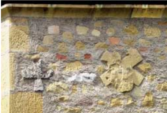
Auf der Frontseite des Chors mit dem 1528 datierten Gesims sind zwei Werkstücke eingemauert: links ein Kreuz und rechts ein Schlussstein mit dem Wappen von Louis Colomb, Abt von Fontaine-André.
