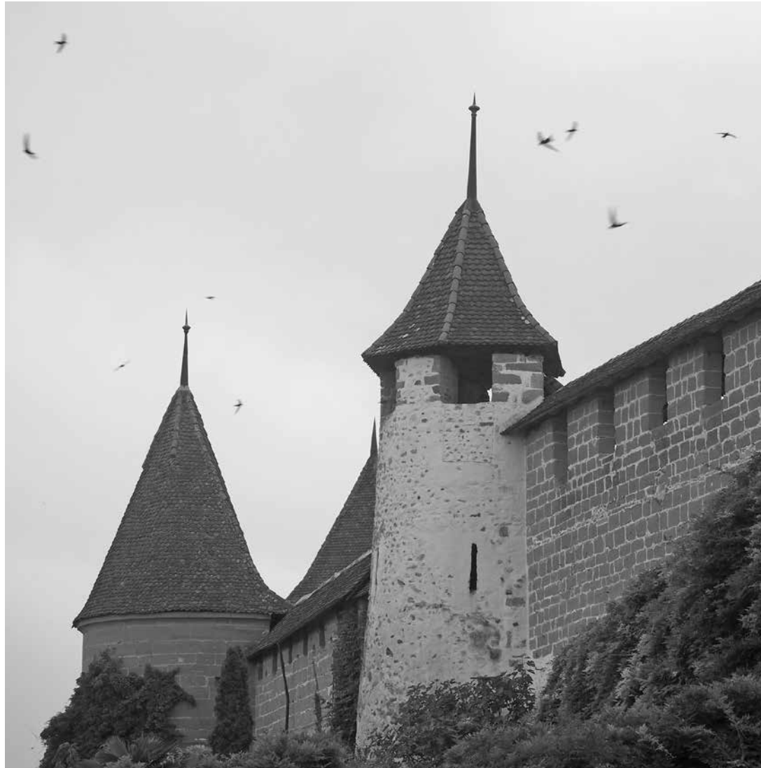
Ringmauer mit Mauerseglern vom Türhplatz aus (Foto C. Riniker)
